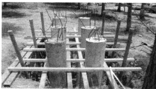
图 1-3 模型桩成桩
