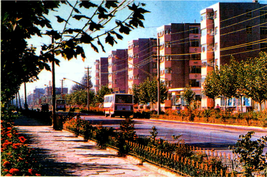
新建住宅楼群
