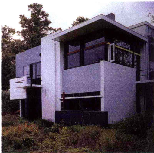
图1-3 施罗德住宅 里特维德
