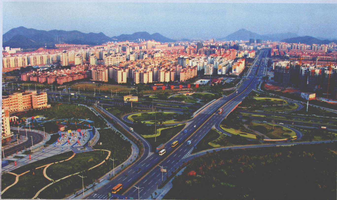
四环路与东莞大道交汇处（张起满 摄）
