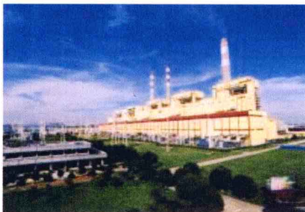
国内最大的火力发电厂北仑电厂
