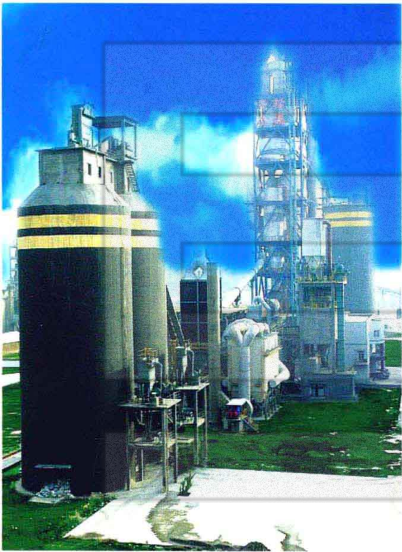
2005年6月，青松建化在乌市建成日产2 500吨新型干法水泥生产线
