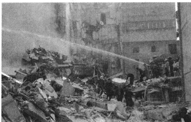
图 1-1 在火灾中倒塌的大楼
