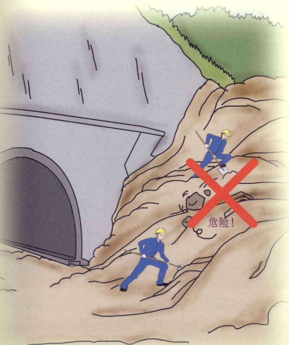
洞口土石方开挖必须按设计要求进行边、仰坡放线，自上而下分层开挖，分层支护。严禁掏底开挖或上下重叠开挖。
