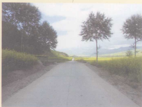
村道硬化工程
