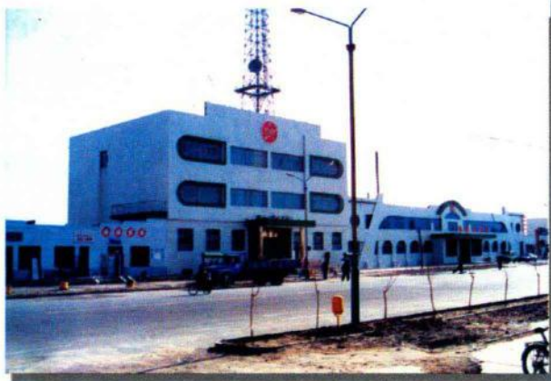
福海县邮电局综合生产楼
