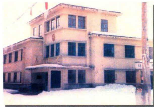
可可托海邮电局综合生产楼
