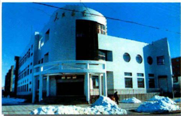
吉木乃县邮电局综合生产楼
