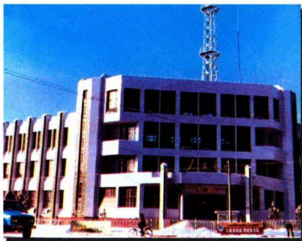
富蕴县邮电局综合生产楼
