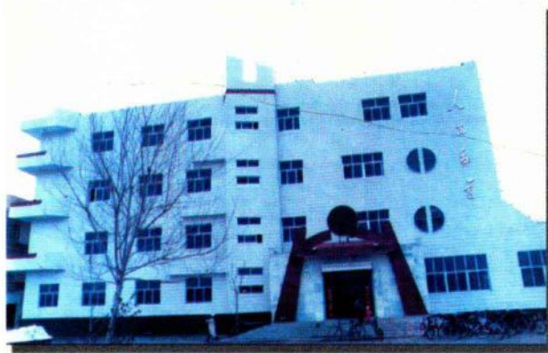
哈巴河县邮电局综合生产楼
