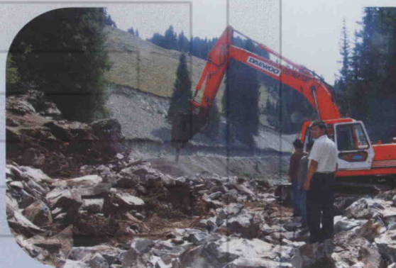
灯杆山公路修建
