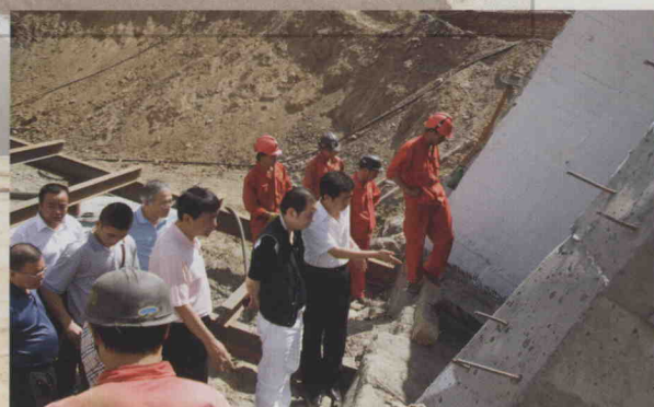
德力西集团董事局主席胡成中在中德伟业 90 万吨技改现场
