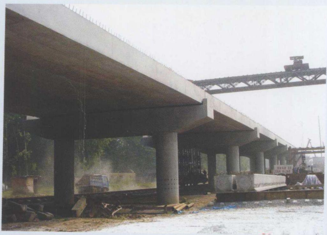
◆ 京杭大运河泗阳三号桥
