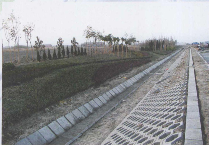
◆ S223 线北沿段绿化、防护工程
