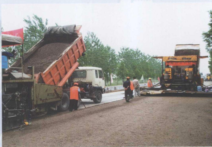
◆ S323 徐海公路双机摊铺水泥稳定碎石
