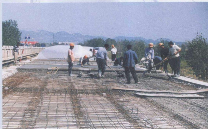
◆ G204 锈针河大桥桥面施工
