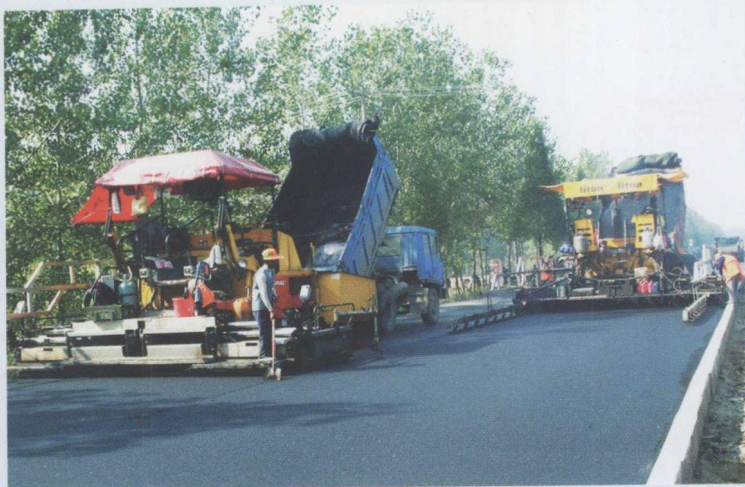
◆ S323 徐海公路沥青混凝土双机摊铺
