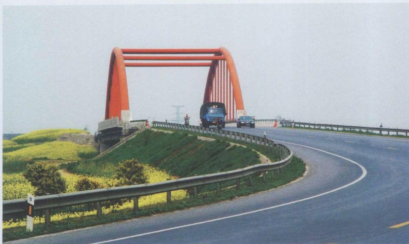
◆ S122 丹阳京杭大运河桥
