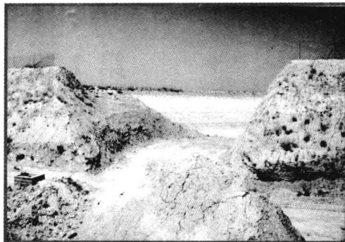
西班牙 San Juan 水库坝体破坏 (引自 F. Gutierrez)
