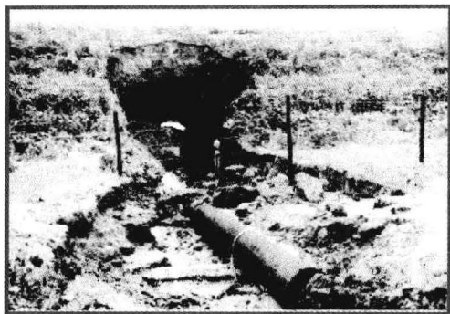
分散性土修筑的堤坝遭到破坏 (引自 Edgar H. Helson)
