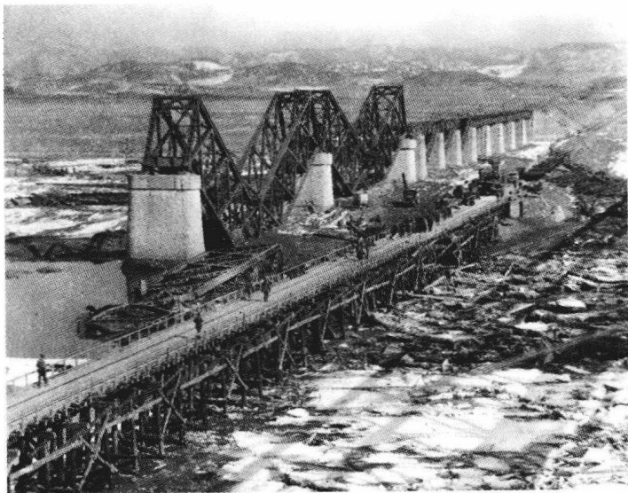
朝鲜北部被美机炸毁的临津江大桥（新华社）
