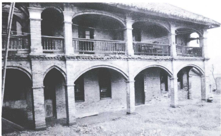
中共潼南第一个支部机关所在地——永绥祠
