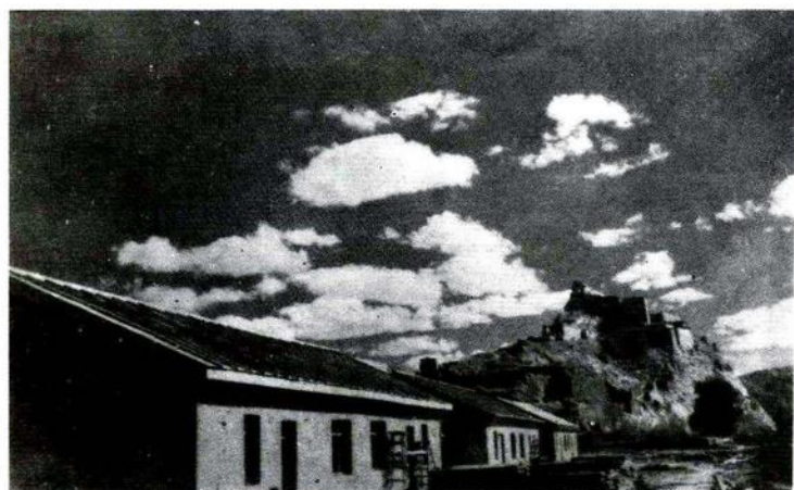
1954年江孜遭受特大洪水灾害后正在盖新房
