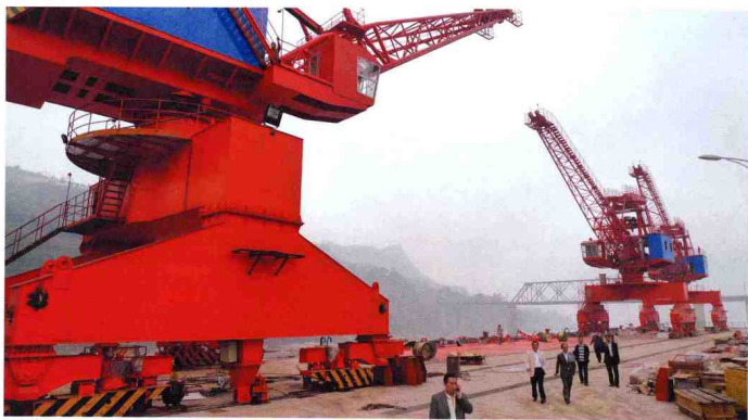
长江第一港——水富港
