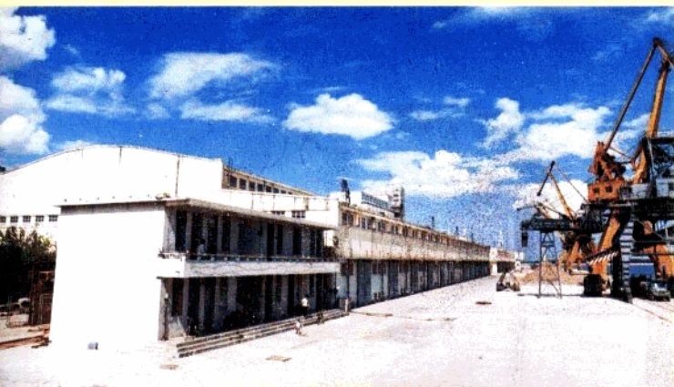
承建的湛江港第一、二號倉 (全優樣板工程)
