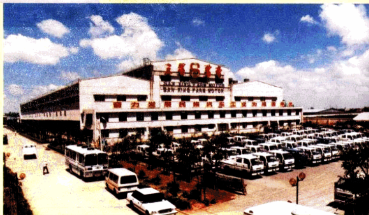
承建的三星農 車集團公司廠房
