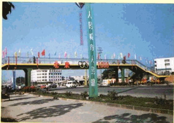
厦门市首座“鼎炉”人行天桥”
