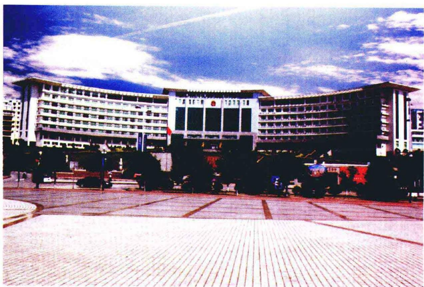
风格独具的党政办公大楼
