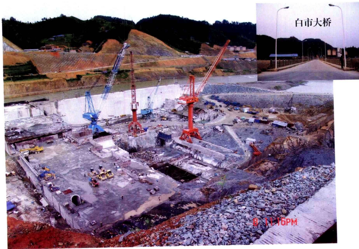
白市电站枢纽工程正在紧张建设
