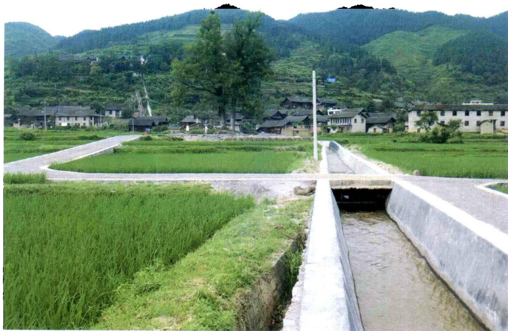
延伸在万亩大坝的机耕道和水渠
