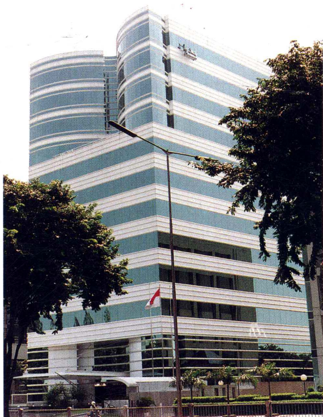
▲ 椰加达市 BRITower 塔楼。 BRI Tower, Jarkata.
