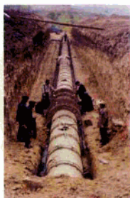
◆ 扶贫扬黄灌溉工程
