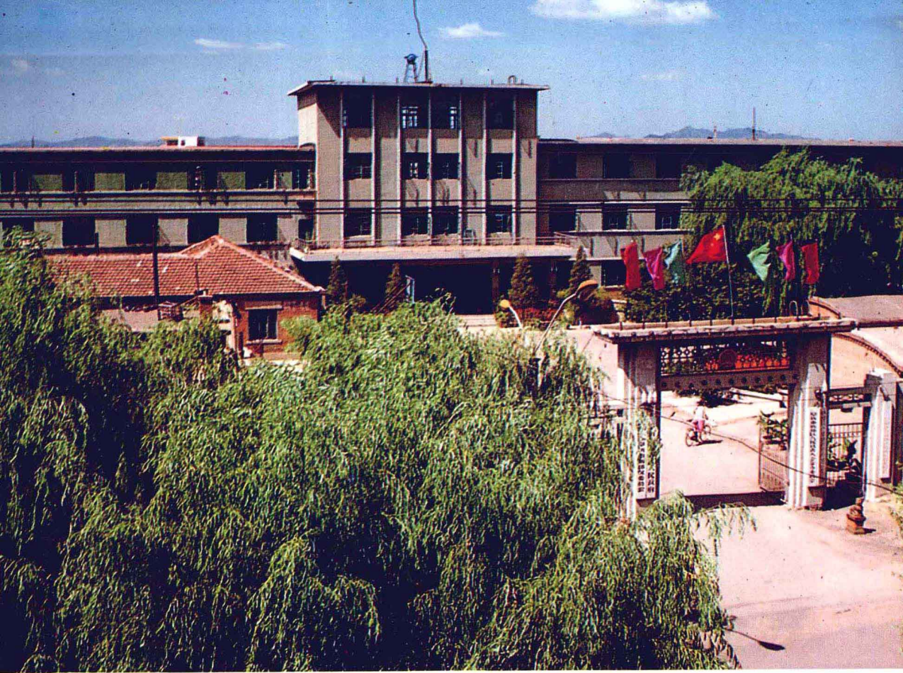
区机关办公楼
