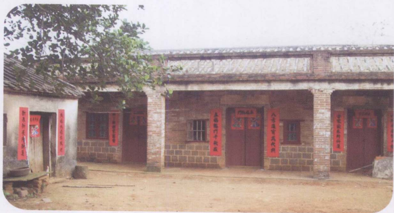
下洋镇桐挖村王显善家宅（现貌）。1949年初，恢复后的徐闻县交通联络情报总站移设于此，王显善任副站长。
