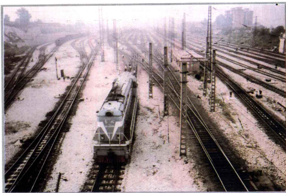
铁路(贵阳南站)
