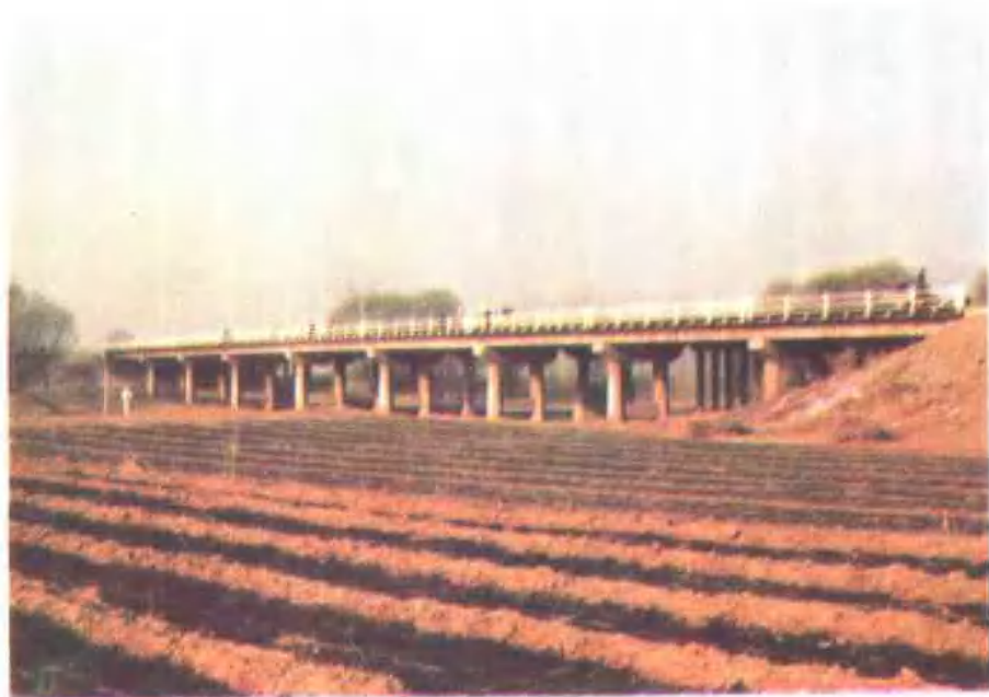
京哈线上的沿口桥
