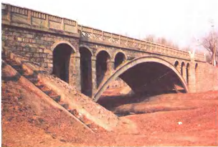
三河南关双曲拱桥
