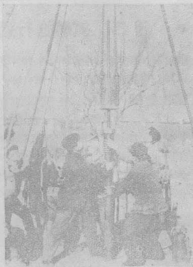
第 9 圖 打入第一根套管
