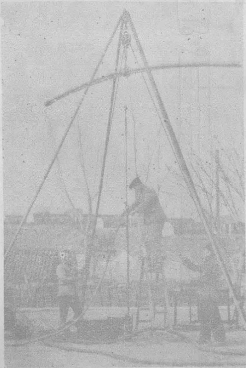
第11圖A 竹弓沖洗鑽孔
