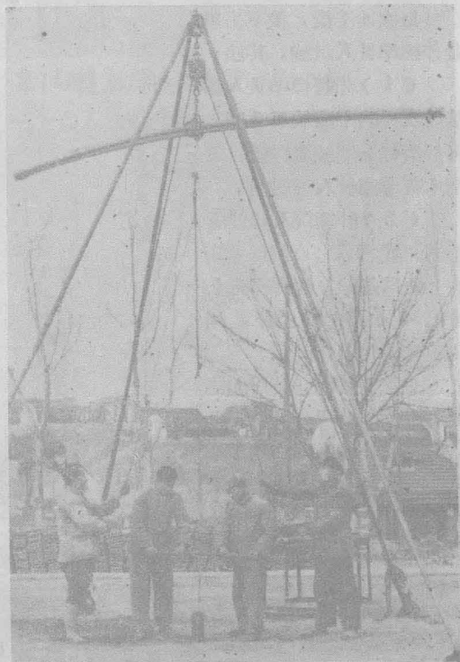
B 搗土汲泥筒鑽孔
