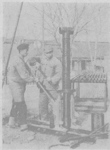
第18圖 拔出套管
