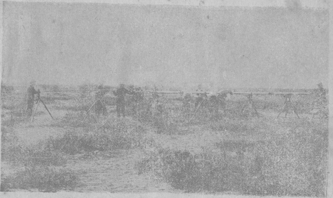
鍊鋼合金尺未發明前，用愛姆伯基線桿量基線之情況。
