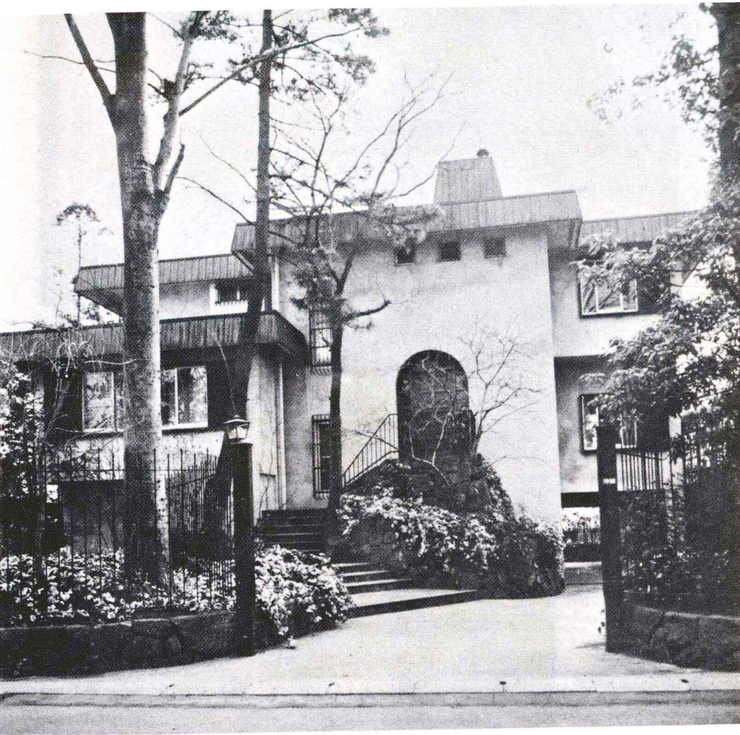
▲此宅以白壁正面拱型正門爲中心，屋簷下橫板裝得很大，門牆是疊石子，上面裝縱格子的籬笆，門柱裝洋式柱燈，院子的樹木多，爲歐洲式的前面庭園。
