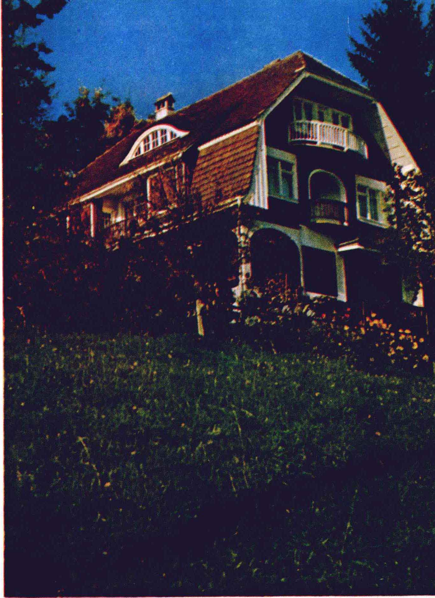
▲此為興建在瑞士山岳地帶的住宅。紅茶色的外壁，和顏色相同的木製的開關，白色窗框像浮雕那樣優美，復斜屋頂蓋天然石板。屋頂下的房間小窗為單純形態的屋頂增加變化，跳台的圓形扶手和屋頂窗的小屋頂的優異形態很有趣。
