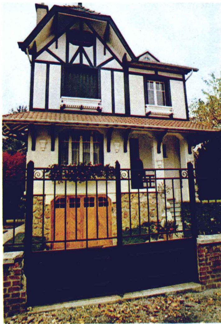
▲噴石膏粉的白壁和紅磚的住宅，二樓以上設柱和樑裝成像木造建築樣子，白色門的外面裝朱古力褐色的百葉窗，支撐一樓屋簷下的傾斜支柱是圓形的，上面的煙囪增加屋頂變化。三樓的窗子用玻璃切成小六角型。半地下室的正面為車庫。
