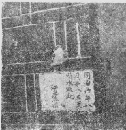
圖 4 *鄖县城內察院巷江光杰老屋 天井內院磚牆上洪水痕跡
