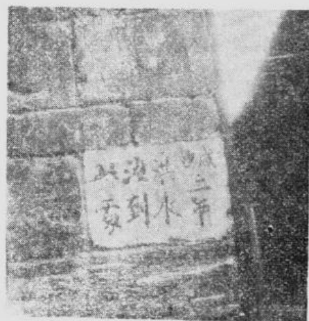
圖 5 *鄖西夾河关上太山廟側牆上 洪水痕跡
