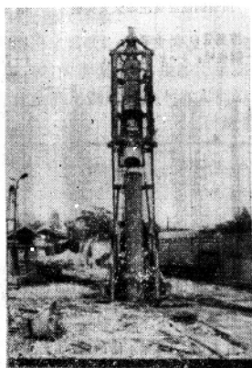
图 3 “贝诺托”桩架
