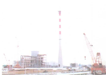
建设中的主厂房和已结顶的180米高烟囱
