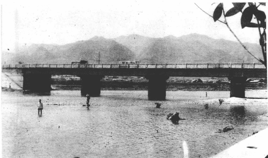
320 国道芦溪公路大桥飞架袁河
