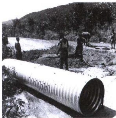
IDA提供资金，帮助人们获得教育、保健、洁净水和公共卫生等基础服务，并提高这些服务的质量。IDA为赞比亚的公路项目提供资助。图为该项目下的电缆管道正在修建之中。
