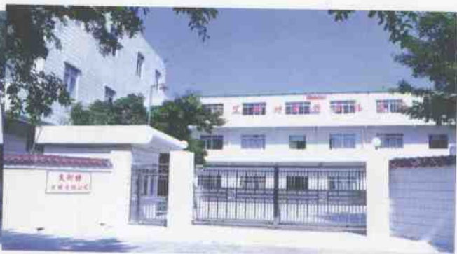
△引进台商开发建设的美斯特皮饰有限公司厂房门面
