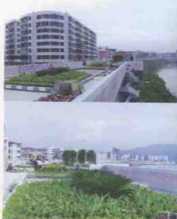
△上二图为堤上园林景 堤园工程商铺的一段▷
