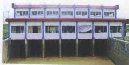
△电排站进水池
