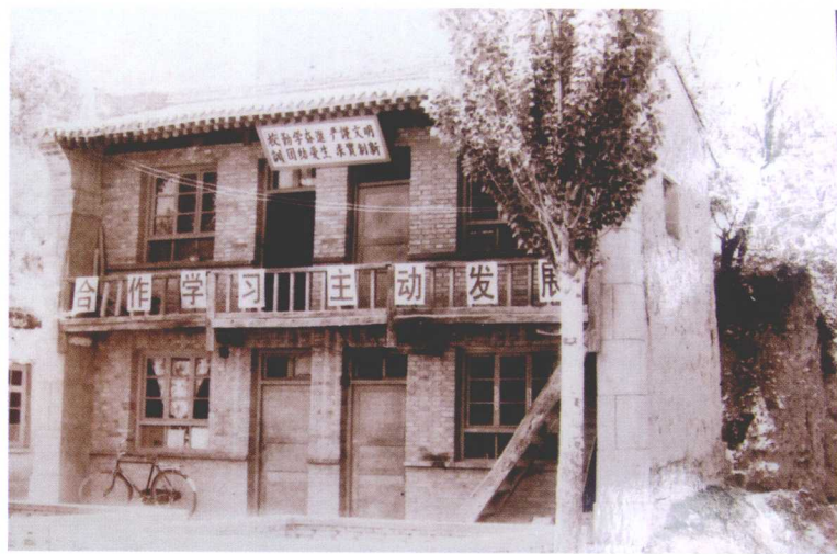
盐井小学改造后的旧土楼正面
