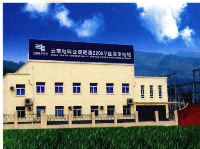
椒子 220 千伏盐津变电站
