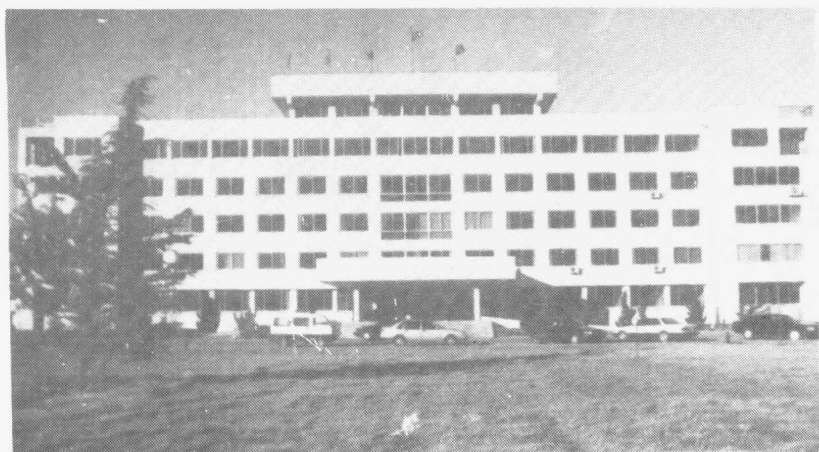
中共抚宁县委办公楼于 1993 年 7 月 15 日开工,1994 年 11 月 10 日竣工。建筑面积 8458.08 平方米(其中车库及宿舍 2275.64 平方米)。
