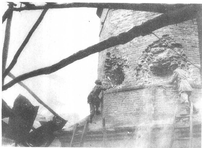
（现一矿）图为我工兵战士正在爆破新矿大烟筒的情形。
