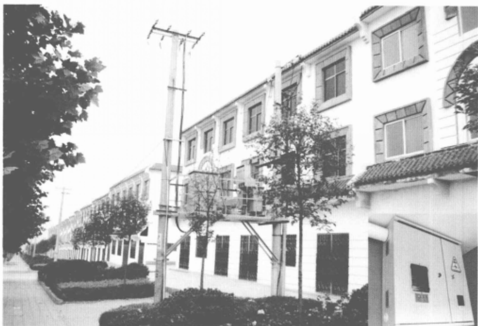
图九 采用柱上变的供电模式及非金属表箱在新农村电气化村的应用
