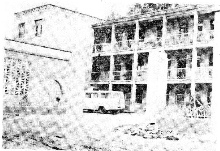
南阳县卫生学校门诊楼
