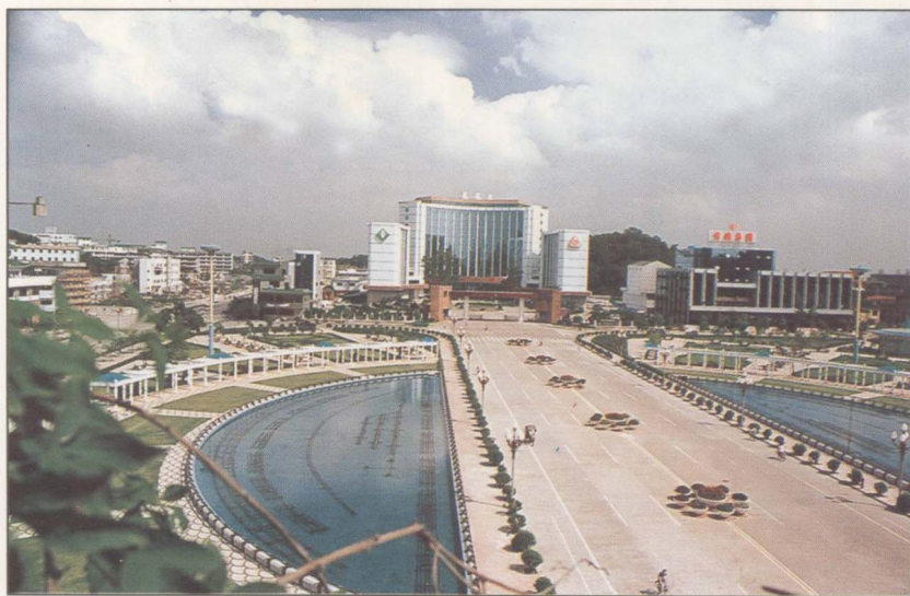
市政府大楼及钟楼公园
