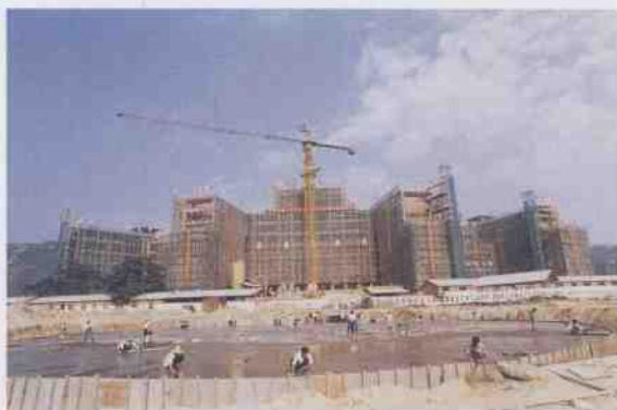
▲在建中的龙洞新校区教学大楼
