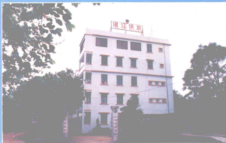
管理所办公大楼
