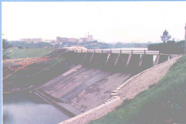
赤坎水库溢洪道景色
