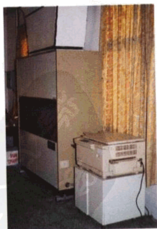
库房部分设备
