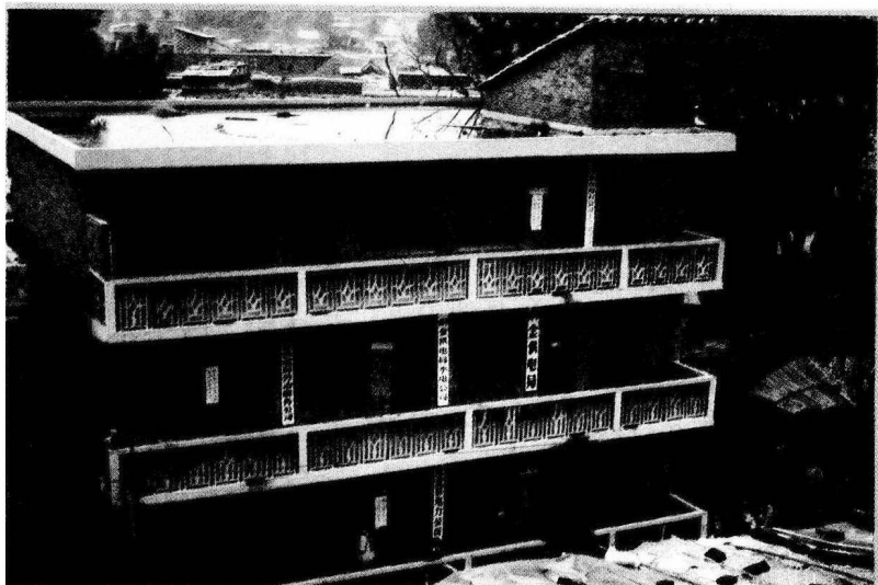
织金供电局大楼 摄影：彭哲义
