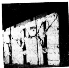
(a) 混凝土内纵墙
