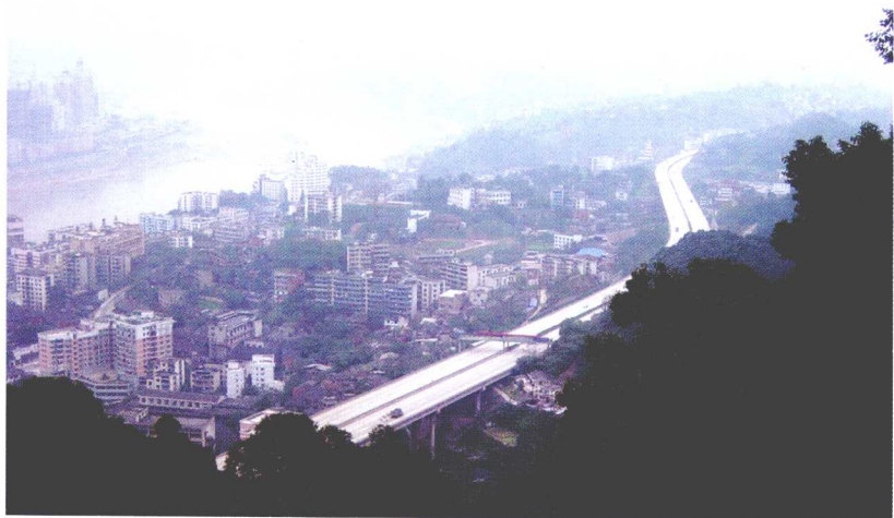
渝黔高速公路南岸段
