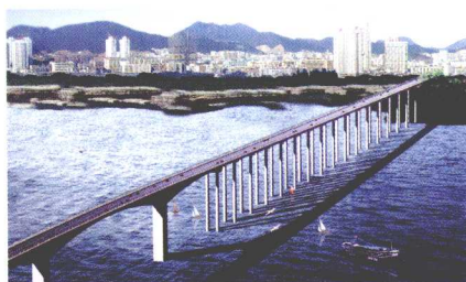
在建设中的重庆广阳岛大桥
