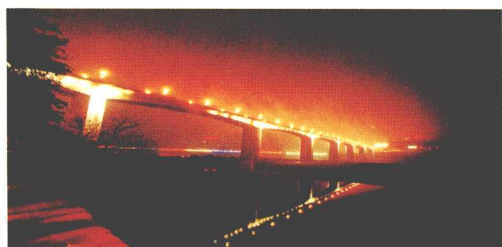
重庆石桥坡长江大桥
