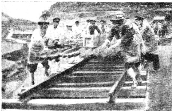
(施一鋪一照一16-7) 小平車推運鋼軌及配件至作業頭情況。
