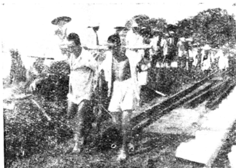
(施一鋪一照一16--2)初期鋪軌抬軌的情況。
